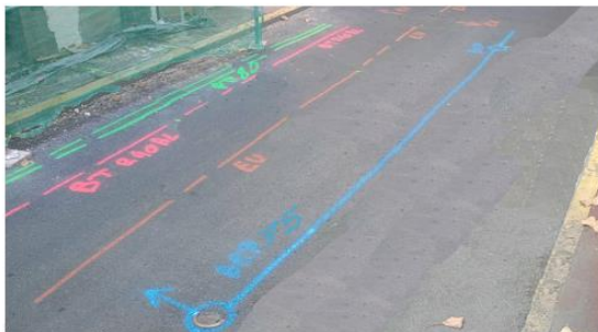
Marquage piquetage du chantier
