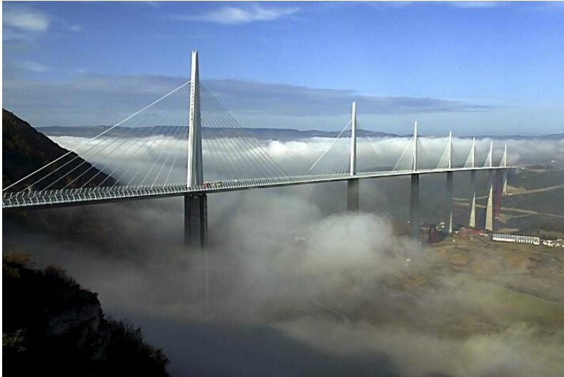
Surveillance d'ouvrages d'art
