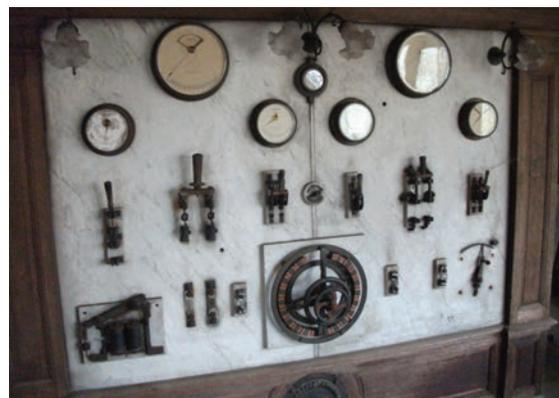
2 Le tableau de régulation et de distribution de l'énergie électrique d'origine
