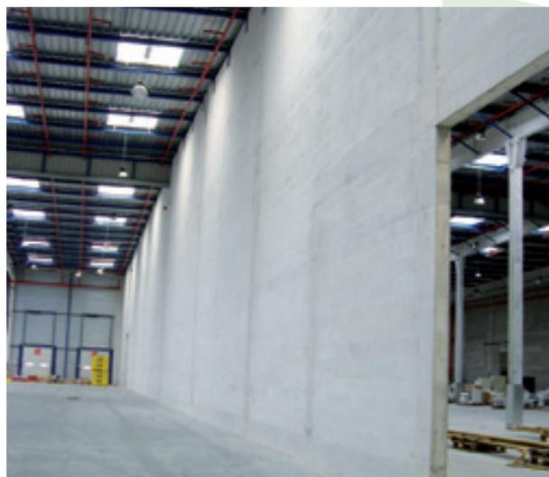
**Le plus pour le collectif :** La résistance au feu d'un mur en béton cellulaire d'épaisseur 25 cm soumis à une charge de 20 tonnes (100% de la charge nominale) dépasse 3 heures (essai réalisé par le CSTB sur des produits de l'industriel Xella Thermopierre).
