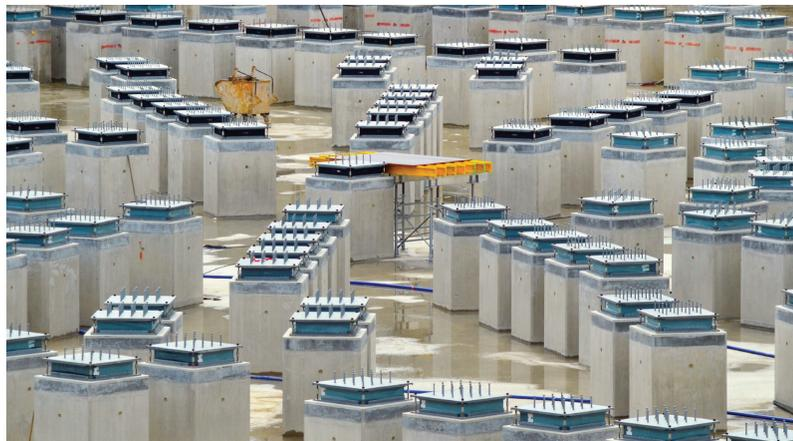
Le réacteur reposera sur 493 colonnes antisismiques
