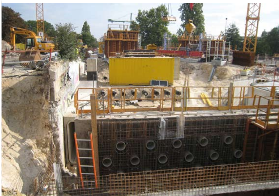
Construction du puits canadien / Photo : Epicuria architecture
