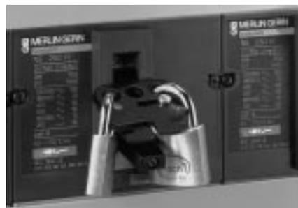
fig. 23 : dispositif de cadenassage sur un disjoncteur Compact (Merlin Gerin).
