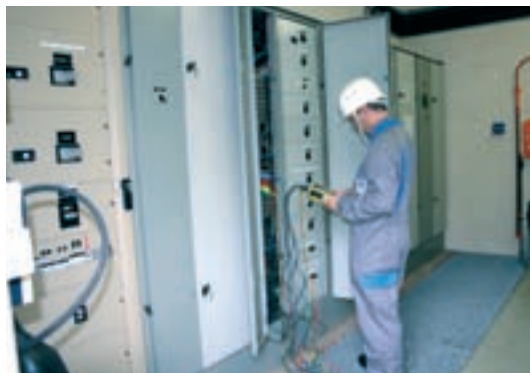
Intervention sur TGBT
