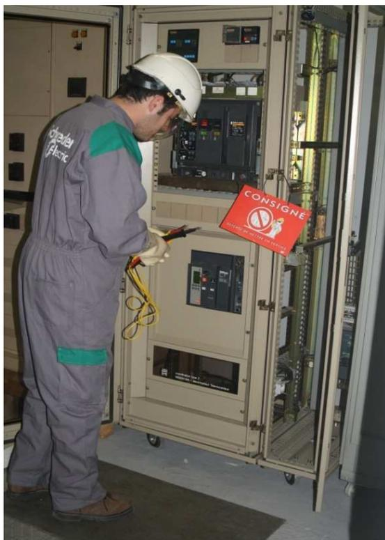
Mise en œuvre des principes de protection du voisinage
