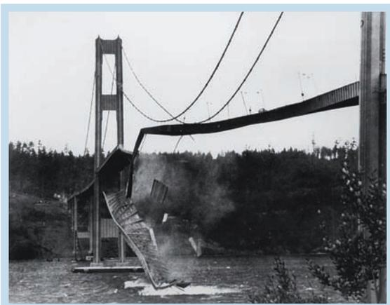
12 L'écroulement du pont de Tacoma
