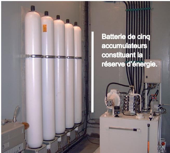
En fonctionnement « normal », c'est l'énergie provenant de la centrale hydraulique qui est amenée dans le vérin. En cas de coupure d'électricité, il faut ouvrir la vanne 2 voies. L'énergie stockée dans l'accumulateur est alors disponible à l'entrée du distributeur. Il suffit de piloter manuellement le pré-actionneur pour amener l'huile sous pression de l'accumulateur vers le vérin.
