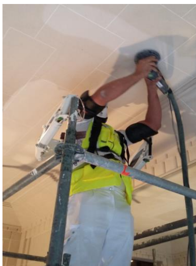
Figure 36. Dispositifs d'assistance proposés par Exhaus® (©INRS/STUC & STAFF)
