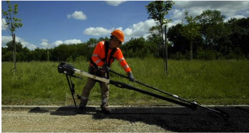
Figure 39. Travaux de TP assistés par Exopush 4 (Crédits Colas-Sphère communication)
