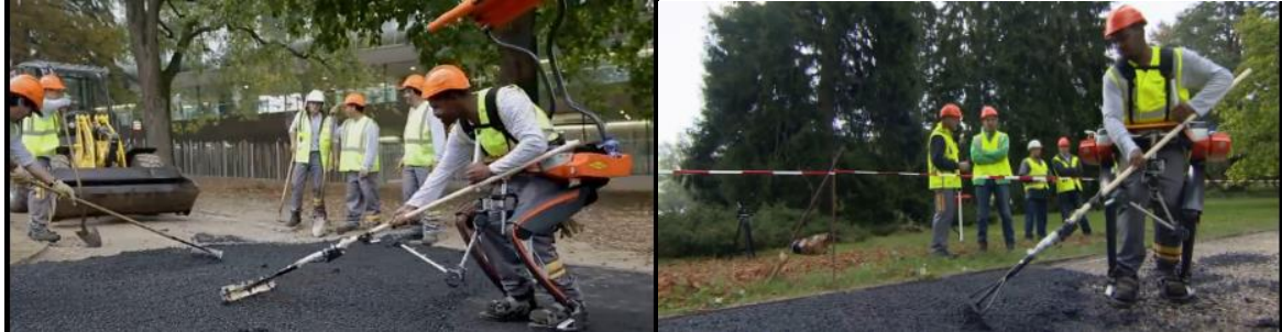
Figure 20. Travaux de BTP assistés par Hercule (Crédits photos Colas)
