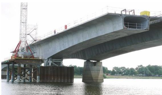
Figure 6 : Fléau lors de la construction du pont du Cadre Noir (Saumur), image J. Mossot Structurae [4]
