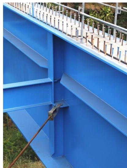
Figure 15 : Raidisseurs longitudinaux et verticaux, Pont sur la Ravine de la Saline (île de la Réunion), image J. Mossot Structurae [4]
