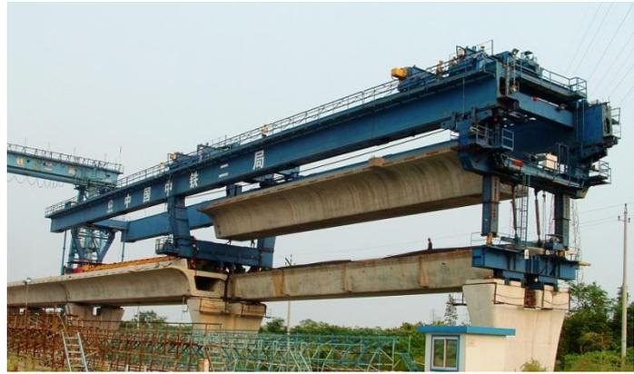
Figure 13 : Poutre caisson métallique, mise en place d'une poutre caisson en béton, Images SBS [6] et BBE [8]
