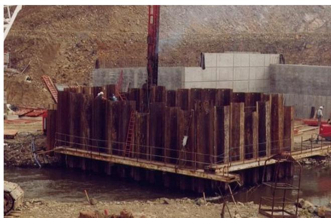
Figure 11 : Mise en place de palplanches pour constituer un batardeau, Pont de la Vire (Manche), Image A. Lemaitier Structurae [5]
