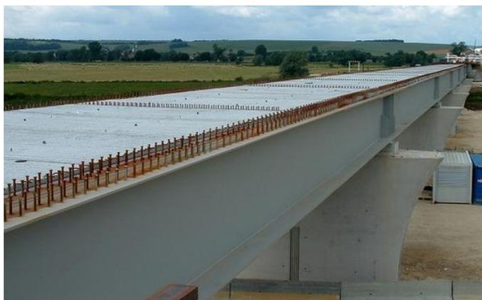
Figure 10 : Pose du hourdis, viaduc du canal de l'est (Meuse), image J. Mossot Structurae [4]
