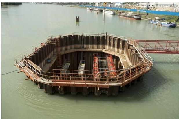
Figure 1 : Batardeau de la construction du pont Raymond Barre à Lyon dédié au tramway, Image SYTRAL [1]
