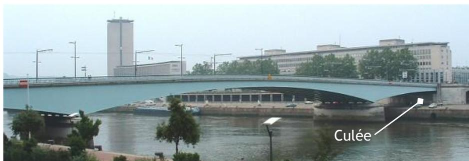
Figure 5 : Le pont Jeanne d'Arc sur la seine à Rouen, Image Luc Nueffer, Structurae [4]
