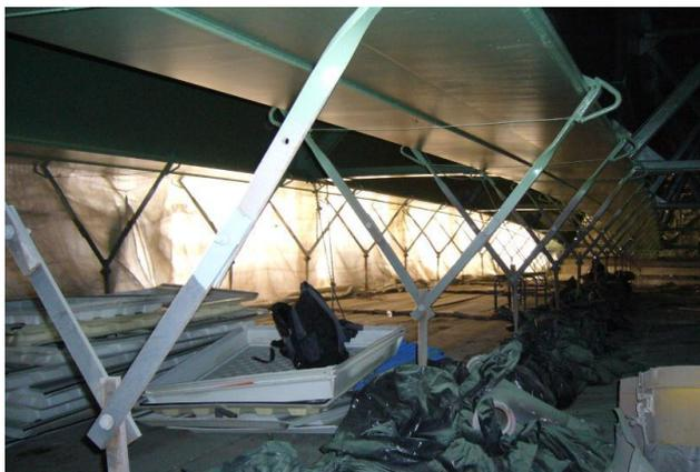
Figure 12 : Le platelage installé aux semelles inférieures des poutres via les pinces
