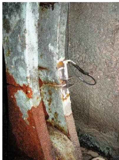
Figure 7 : Bielle corrodée équipée d'un capteur de déplacement
