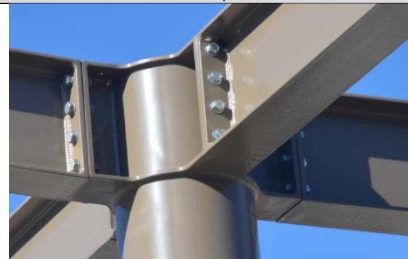
Assemblage poutre/poutre (moignon)
