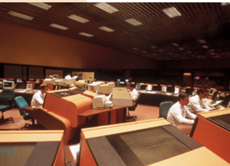
Salle de conduite.
