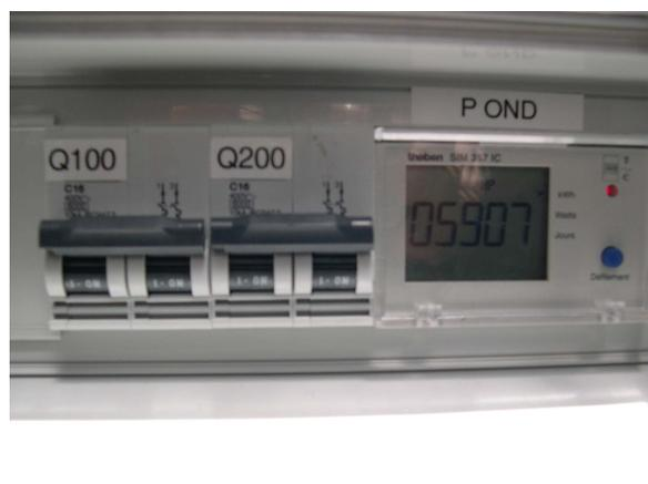
**Les disjoncteurs Q100 et Q200 sont respectivement placés en sortie de l'onduleur 1 pour Q100 et l'onduleur 2 pour Q200. Les 2 onduleurs sont couplés en parallèle après les disjoncteurs et un compteur d'énergie est implanté après le**
