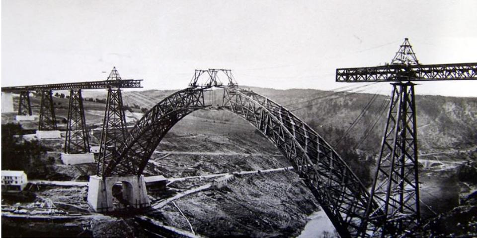
Figure 26 : Viaduc de Garabit lors de sa construction en 1880 par G. Eiffel, image [16]
