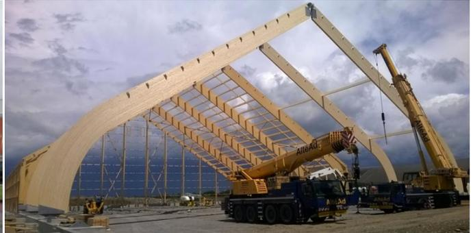
Figure 32 : Montage par grue de la structure en lamellé-collé, portée 50m, image [22]
