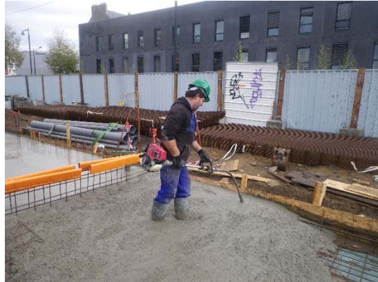
2 - Vibration du béton
