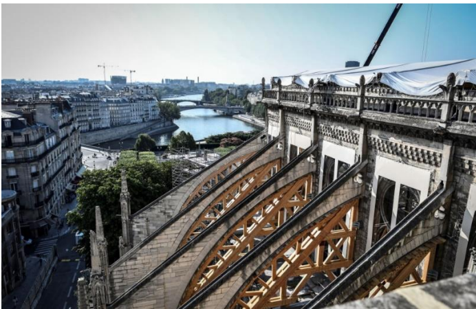
Figure 15 : Arcs-boutants renforcés par des cintres en bois, sources [36] [37]
