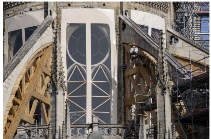
Figure 15 : Arcs-boutants renforcés par des cintres en bois, sources [36] [37]
