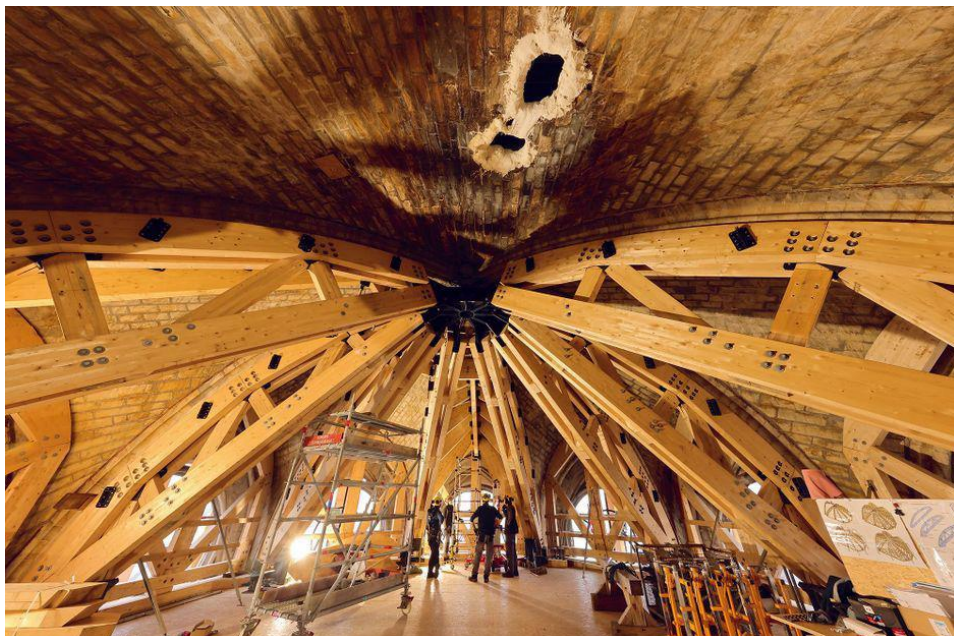
Figure 18 : Une des structures en place sous une voûte, source [38]
