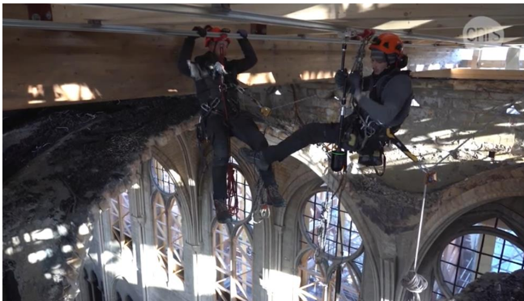
Figure 11 : Installation d'un dispositif de numérisation façade numérisée de Notre-Dame par le CNRS, image extraite de source [27]
