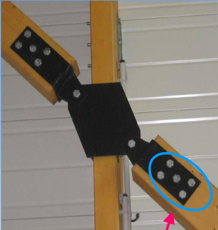
4 – Rupture de bloc par cisaillement et/ou arrachement de l'assemblage complet
