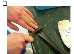
Découper 3 à 5 cm de gaine et la positionner pour qu'elle recouvre le connecteur et la gaine du câble
