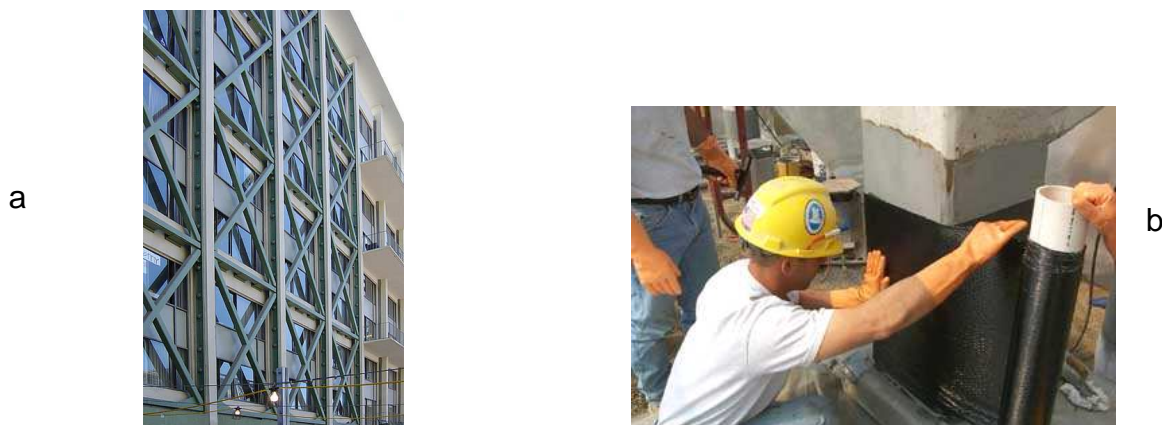
Figure 17 : a) renforcement par contreventements métalliques extérieurs (ph. Common), b) renforcement par collage de tissus de fibres de carbone autour d'un poteau en béton armé (ph. Sika)
