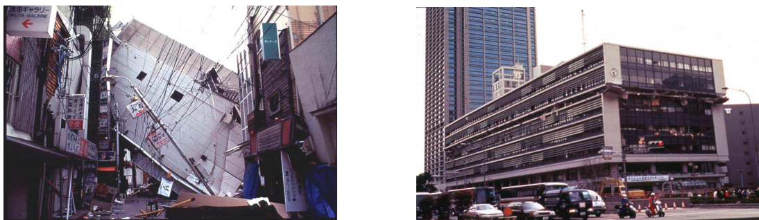
Figure 18 : Effondrement d'immeubles, à gauche, effondrement du fait d'une faiblesse de structure en rez-de-chaussée (transparence) ; à droite, effondrement d'un étage, du fait d'une liaison (passerelle) qui a constitué une butée durant le mouvement entre deux blocs d'immeubles de différentes hauteurs.
