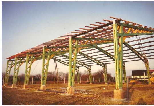
Figure 10 : Exemple de constructions compatible avec un schéma à un degré de liberté : à gauche château d'eau en béton, à droite construction en portique bois
