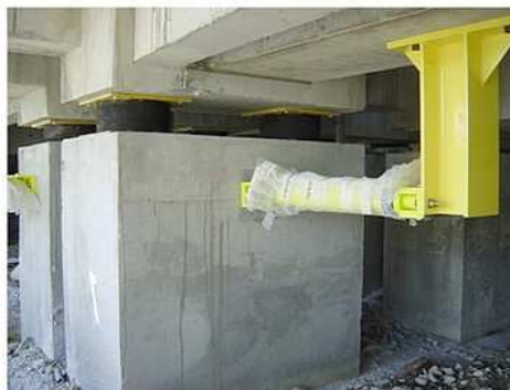
Figure 16 : principe de l'isolation sismique, filtrer et amortir le mouvement sismique : à gauche schéma, à droite sa mise en œuvre dans un collège en Martinique (photo CRM).
