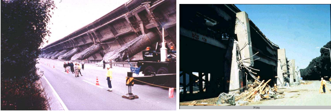
Figure 19 : Effondrement de ponts ; à gauche, pont construit en pendule inversé (masse sur tige) et à gauche rupture d'un pont du fait de la faiblesse de la liaison entre les 2 tabliers superposés.
