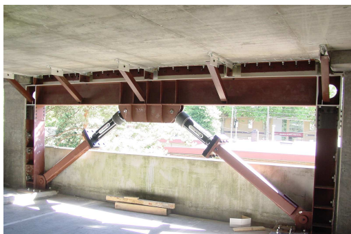
Figure 16 : a) contreventement amortissant au sein d'une structure en béton (ph. Staleson), b) masse « accordée » en haut de la tour Tapei 101 (Taiwan).
