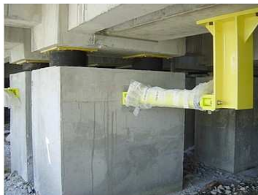
Exemple d'un amortisseur sous un ouvrage en Martinique
