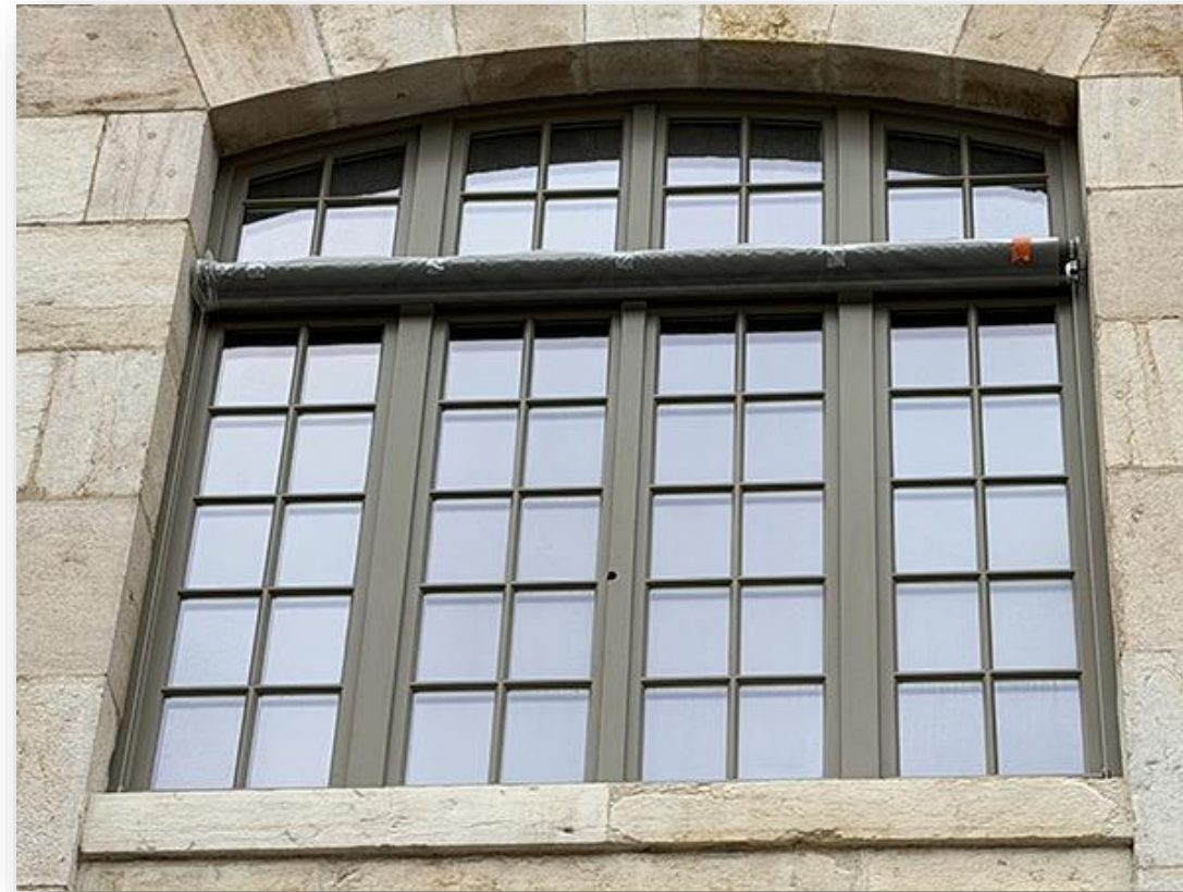
Store occultant - Chantier de l'Arsenal
