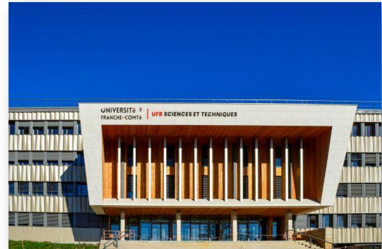
Brise soleil à lames verticales – UFR Sciences et techniques
