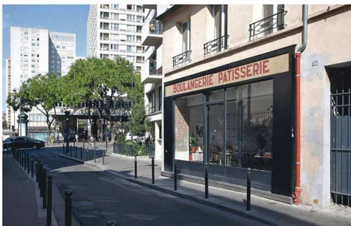
Ancienne boulangerie reconverte en bureaux, 89 rue Pixérécourt (Compans – Pelleport, Paris 19 e )
