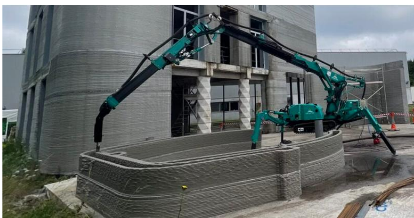
Figure 1 : Bâtiment réalisé en impression 3D béton, source [4]
