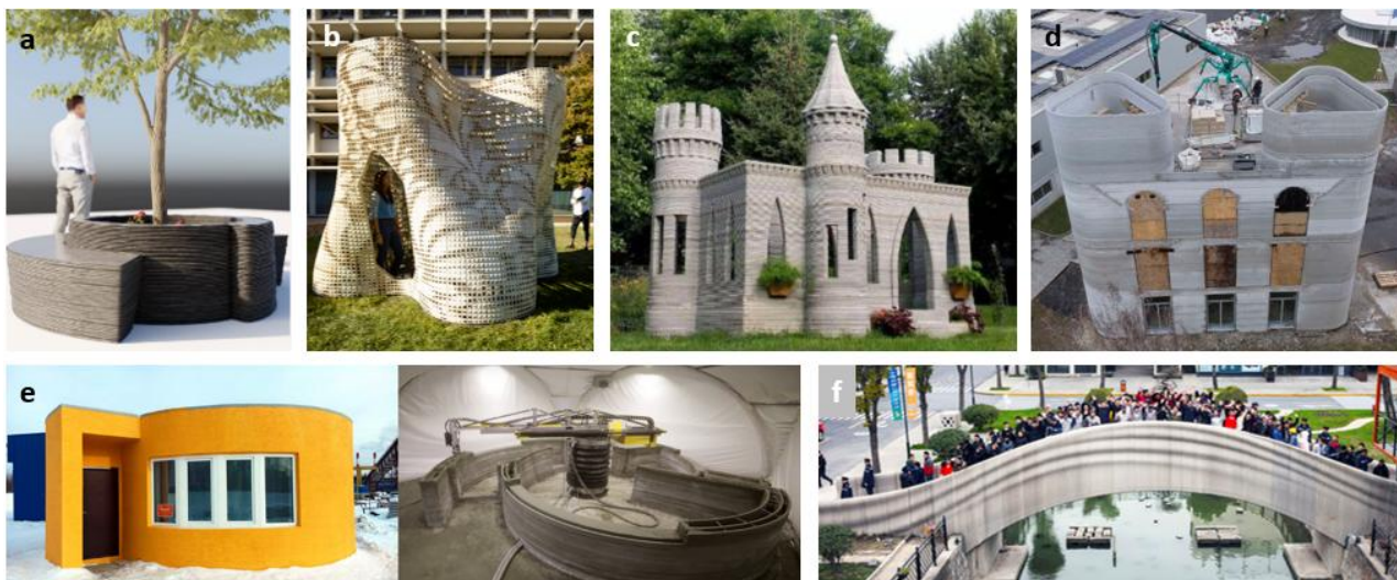
Figure 6 : Pièces réalisées en impression 3D béton : a) Mobilier urbain, source [16] ; b) The Bloom, source [17] ; c) Château en impression 3D dans le Minnesota (USA), source [3] ; d) Citadelle des Savoir-Faire à Bruay-sur-l'Escaut (France) construite en 2024, source [18] ; e) Apis Cor House réalisée en Russie en 2018-2019, source [19] ; f) Passerelle imprimée en 3D à Shanghai, source [20]
