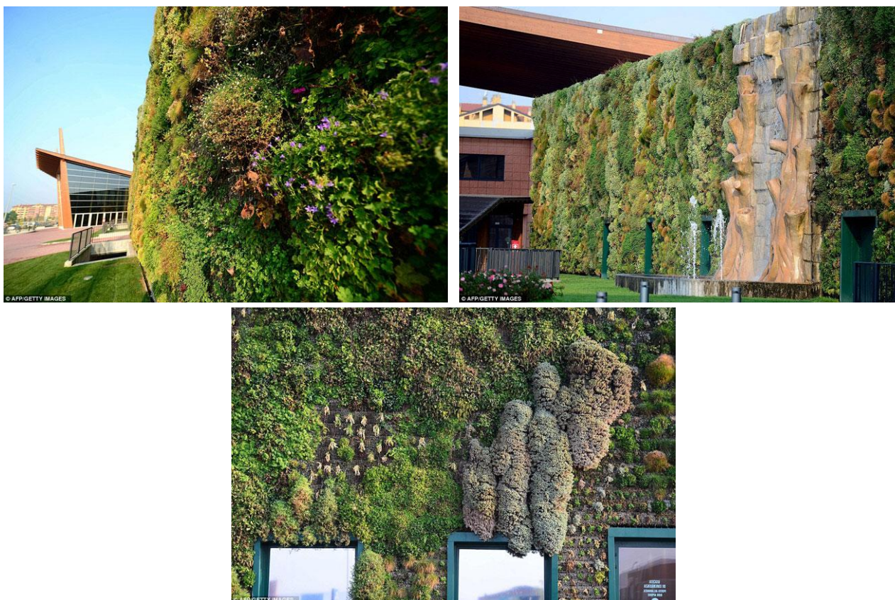
Figure 19 : Mur végétal géant du centre commercial de Rozzano (Italie) [23]
