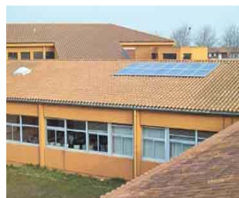
Figure 1 : panneaux solaires sur le toit du Lycée de Colomiers
