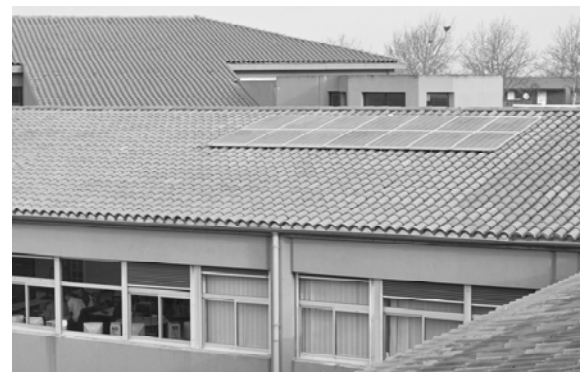
Figure 15 : panneau sur toiture en surimposition (21 m 2 )
