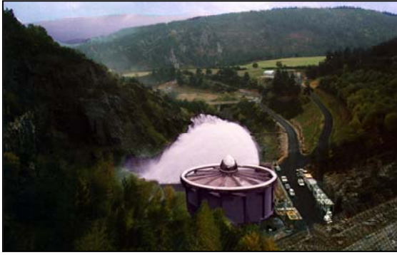
Figure 3 : Vue générale de la centrale de Naussac
