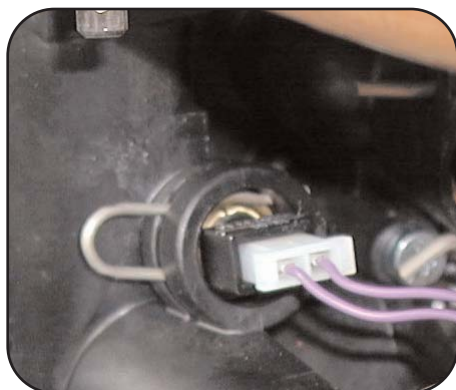
Thermistance Départ chauffage
