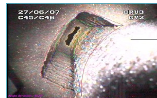
Figure 13 : colmatage entre le tube et la plaque entretoise
