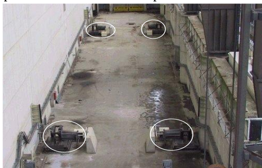
Figure 23 : Photo de la fosse et emplacement des chapes d'arrimage
