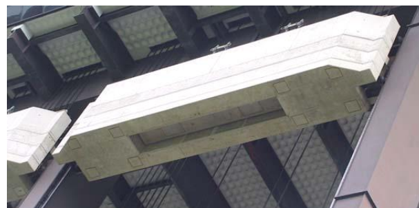
Figure 9 : Contrepoids vue de dessous
