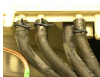
Figure 15 : Durites d'entrée d'eau
