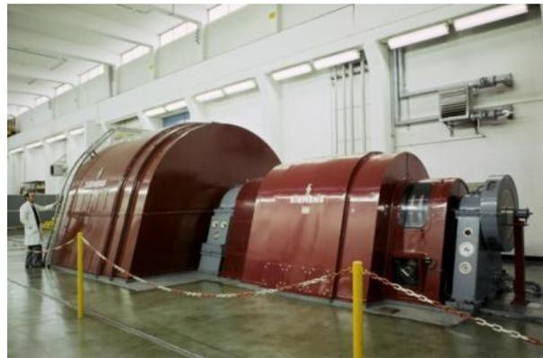
Figure 4 : Le groupe tournant du PS. Le générateur à gauche, le moteur à droite.
