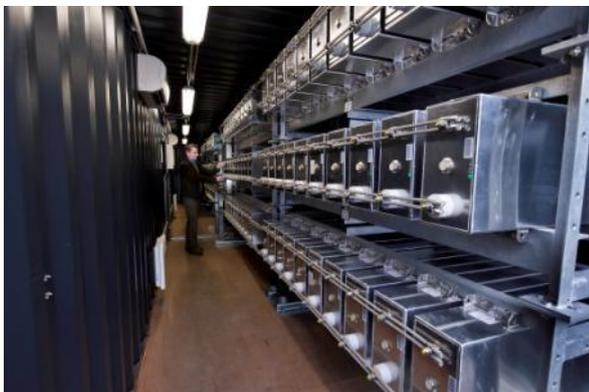
**Figure 14** : un banc de condensateurs placé dans son conteneur
