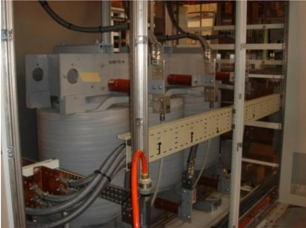
**Figure 21 :** Inductance couplé d'un convertisseur DC/DC
