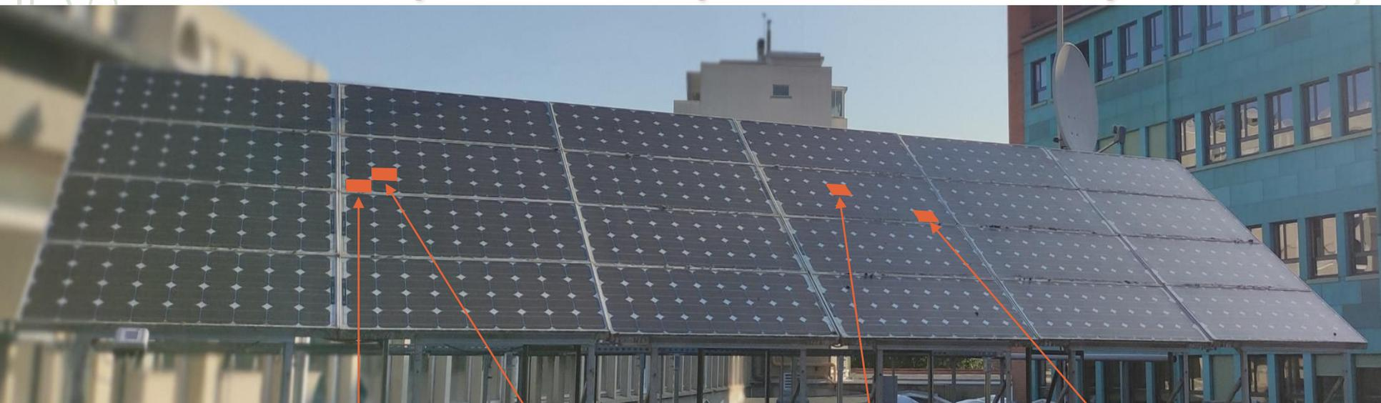
Dysfonctionnement de la partie DC : 4 cellules endommagées repérées en janvier 2025 (grêle ?)
