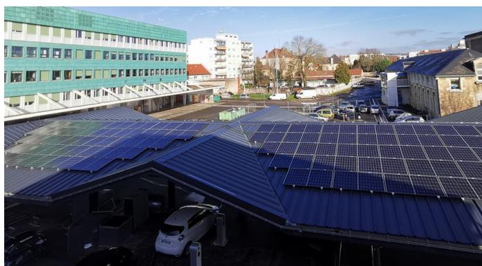
La structure avec onduleur de chaîne est peu adaptée à cette situation. L'utilisation d'un onduleur de chaîne par champ photovoltaïque serait envisageable mais l'impact du masque solaire sur 3 d'entre eux est non négligeable.
