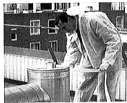
Figure 53 : Mise d'une bande adhésive au niveau du té-souche suite à opération de nettoyage
