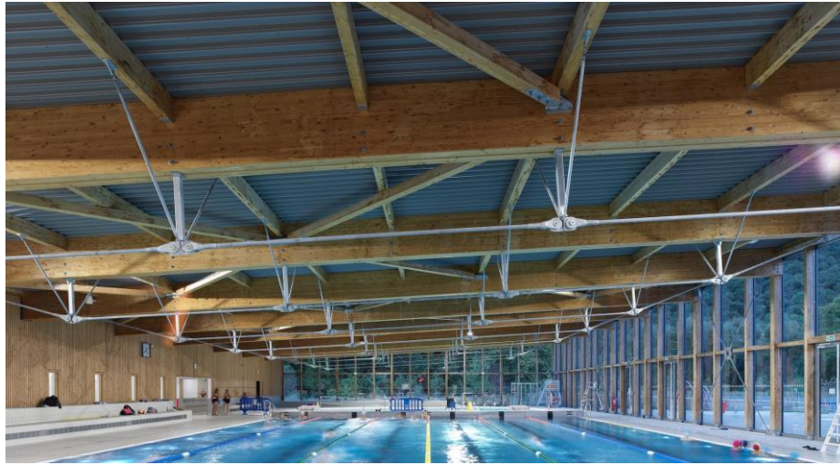
Figure 14 : Détail des portiques composés de poutres BLC reposant sur des poteaux BLC à droite et voile de béton à gauche
