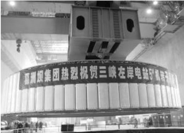
**Figure 8 :** *Descente du rotor dans le puits*
