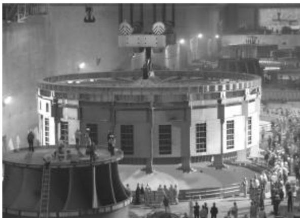
Figure 6 : Descente du stator de Three Gorges dans le puits
