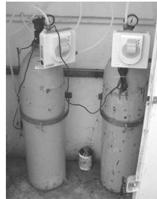
Figure 3 : Bouteilles de chlore
