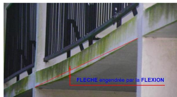
La limitation réglementaire de la flèche est de 1/300 de la portée du plancher ou de la poutre. Dans le cas du plancher de l'immeuble ci-dessus : 4 cm de flèche pour 6 m de portée représentent 1/150 de la portée, soit le double de la flèche autorisée.
