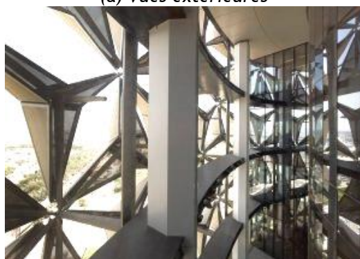
(b) Vue intérieure
