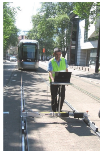
Figure 21 : Mesure d'usure des rails de chemin de fer
