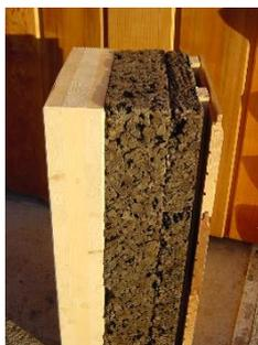
Figure 2 : maquette d'une paroi verticale de la Maison Z.E.N
