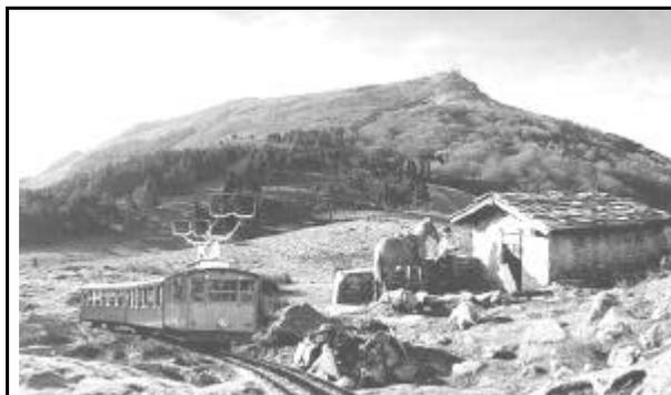
*Figure 206* vue d'un petit train du chemin de fer touristique de La Rhune dans son environnement. On remarquera la taille imposante des 2 archets jumelés de captage du courant sur la ligne à 2 fils de contact.
