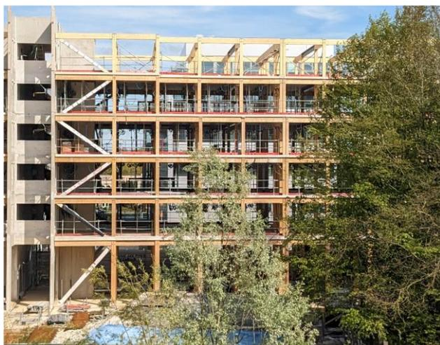
Figure 24 : Bâtiment construction mixte, poteaux et poutres en bois, dalle en béton (plateau de Saclay)
