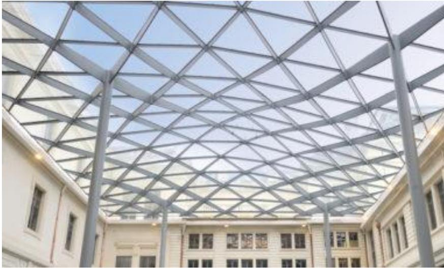
Figure 9 : Profils à inertie variable pour la verrière de la cour du Midi, Lyon [9]
