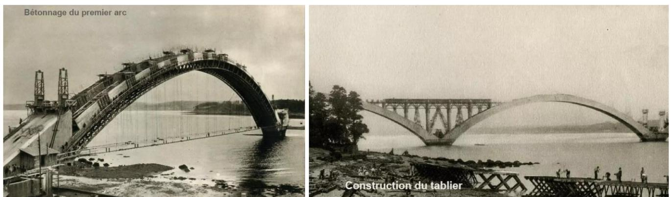
Figure 19 : Construction avec coffrages (arc et tablier) du pont Albert-Loupe [16]
