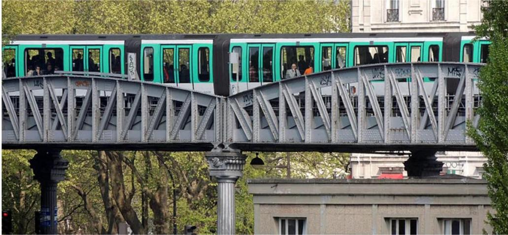
Figure 11 : Metro aerien parisien, les poutres en treillis sont plus epaisses au milieu de la portee qu'a l'appui des poteaux
