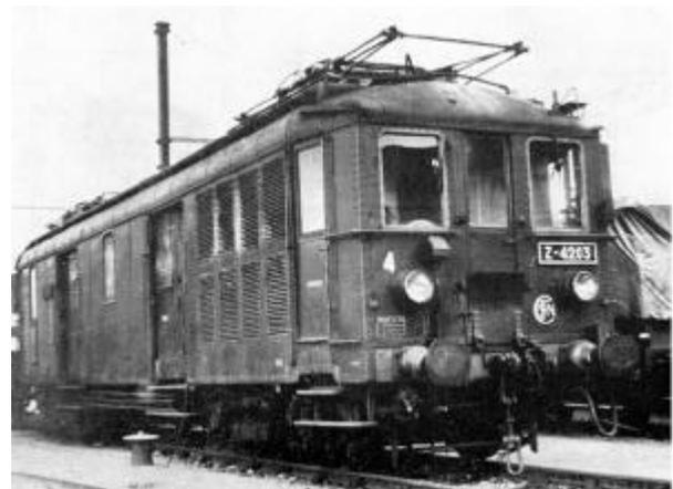
L'automotrice z4203 équipée d'un hacheur expérimental BBC-CEM de 450 kW alimentant 1 seul bogie.
