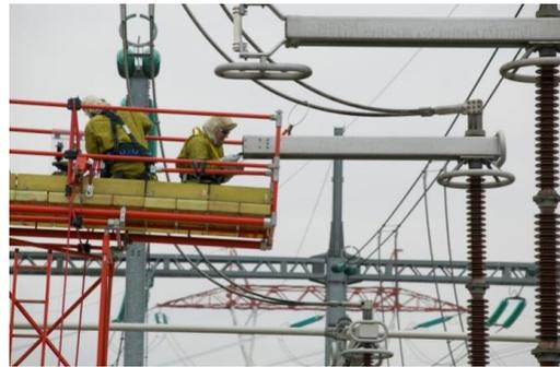
**Figure 11** : cinq postiers équipés d'une combinaison conductrice travaillent sous tension (TST). Ils assurent le remplacement d'un sectionneur des lignes électriques 400 kV alimentant l'agglomération de Toulouse (poste de Verfeil) à l'aide d'une tour isolante de positionnement (TIP) et d'une nacelle. (©Bellavia Christian / RTE 2008)
