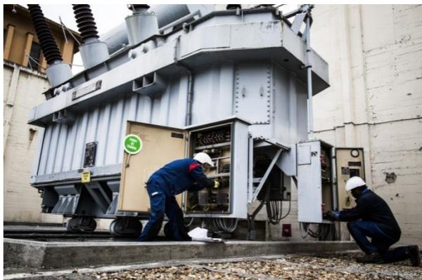
**Figure 2 :** maintenance d'un transformateur au groupement de postes Val de Seine (©Goldstein Julien / RTE 2015)
