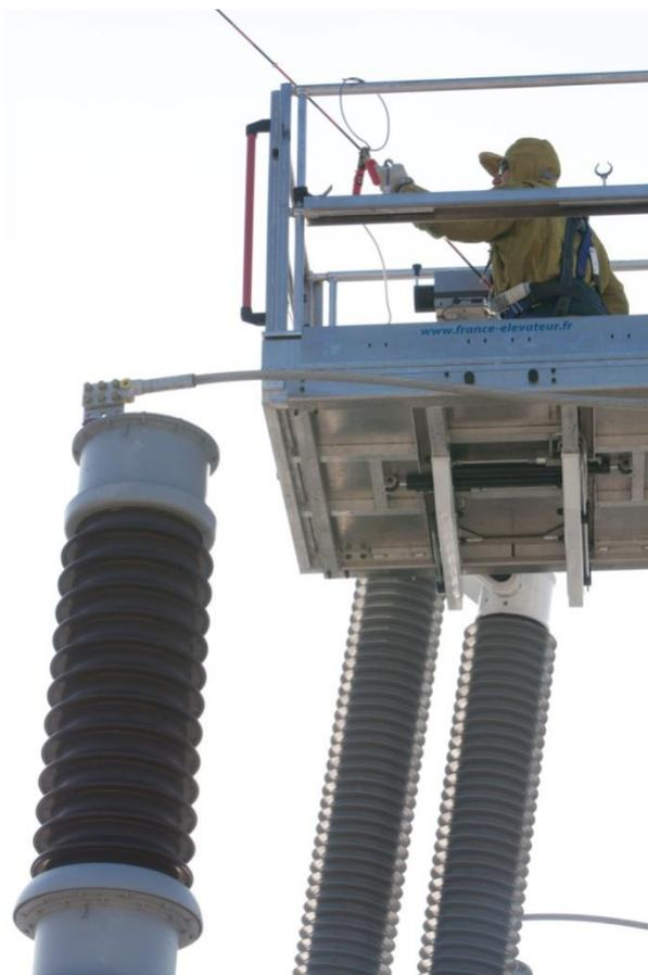
**Figure 8** : essais utilisateurs de la nouvelle plateforme élévatrice mobile (PEMP). (©ULRICH Olivier / RTE 2013)
