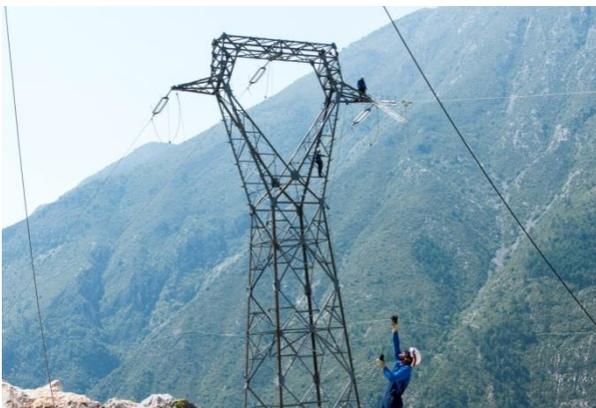
**Figure 1 :** chantier de la ligne 63 kV Bancairon-Courbaisse : agent RTE guidant des agents du GET Côte d'Azur et Cévennes lors de la mise en place du poste de travail de la phase 3. (©ROUX Lionel/RTE 2013)
