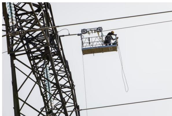
**Figure 4 :** pose de balises avisphères dans le massif de la Vanoise. (@seignettelafontan.com/RTE2017)
