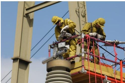
**Figure 10** : réparation de la canalisation à isolation gazeuse (CIG). Les techniciens du GET-Anjou interviennent sous tension grâce à une tour isolante de positionnement. (©Sargos Alexandre / RTE 2006)
