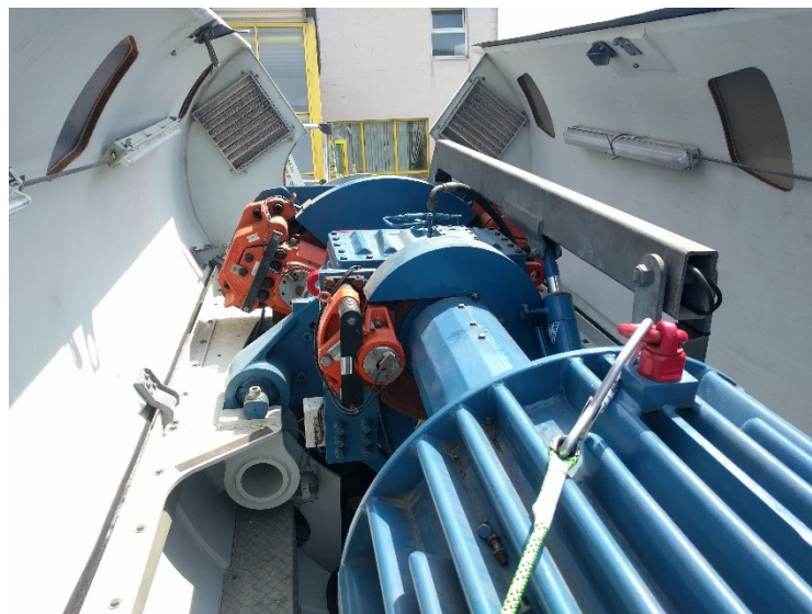
Nacelle dans la cour du lycée
