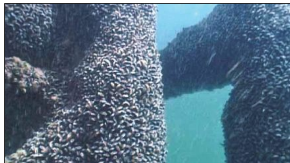
Figure 4 : Colonisation par les moules sur les structures de protection du parc éolien offshore Horn Rev au Danemark.
