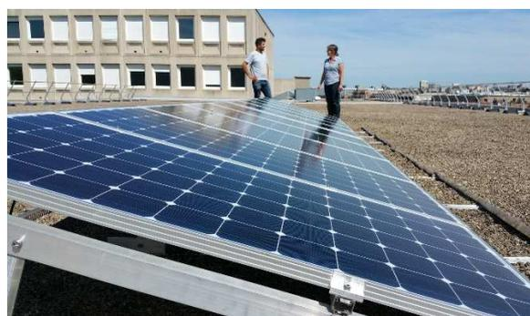
Figure 67 : champ PV du département GIM installée sur une toiture terrasse de l'IUT de Saint-Denis (2kWc - stockage - gestion de l'énergie par un onduleur intelligent IMEON 3.6 d'Imeon Energy36)
